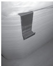
Placér monteringsholderne
